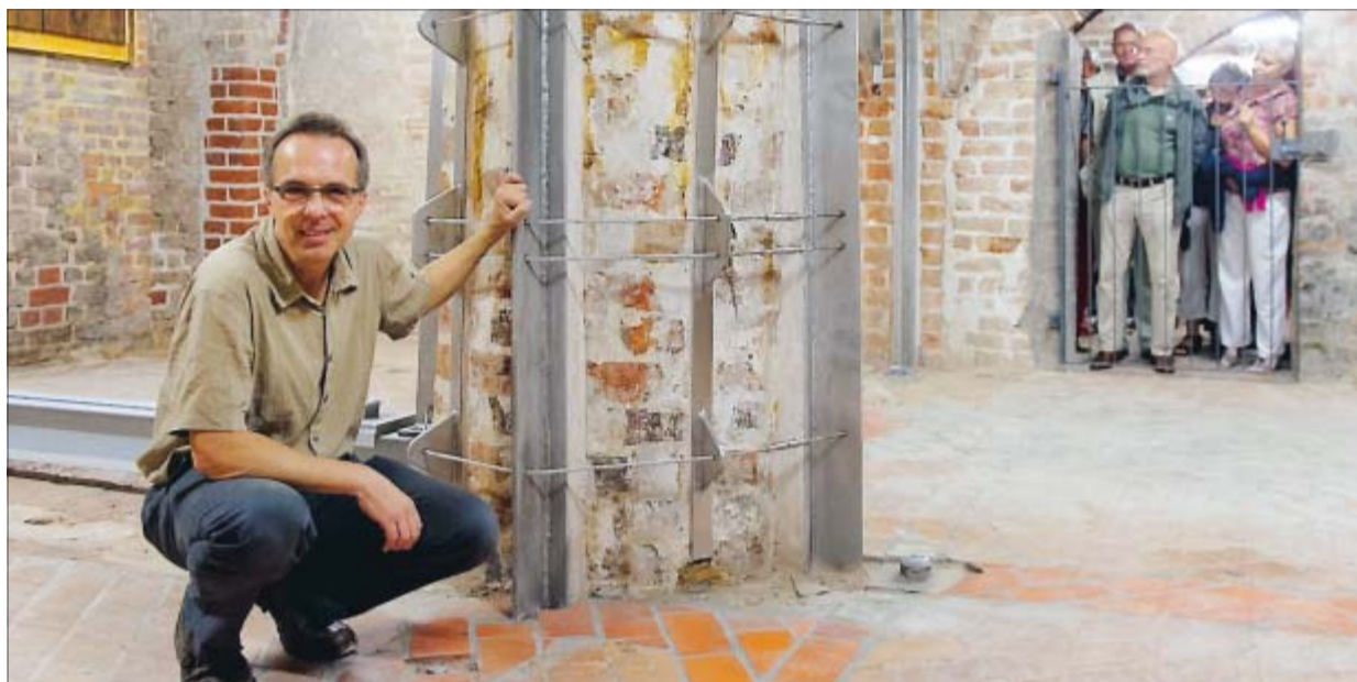
Lennart Hellberg erläuterte im Ambrosiuskeller des Rathauses auch, wie ein Pfeiler durch eine Stahl-Konstruktion gesichert wird. Besucher durften diesen Teil des Kellers nicht betreten, da die historischen Fliesen geschont werden müssen. Foto: t & w
