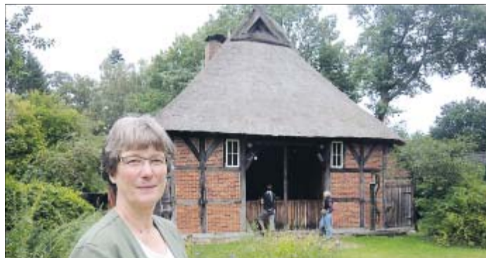
1661 wurde das Zweistöckerhaus gebaut, gestern öffnete Besitzerin Sabine Kühne-Kaiser es für Besucher. Foto: off
